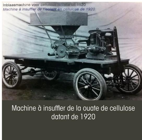
Inblaasmachine voor cellulose isolatie uit 1920
